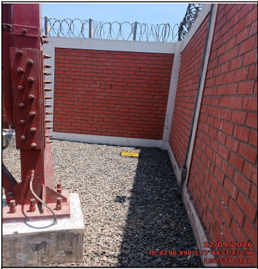
Foto Panorámica del Interior del Site
