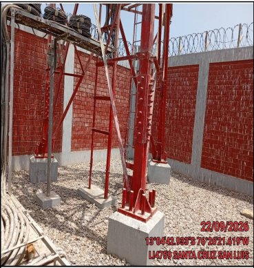
Foto Panorámica del Interior del Site
