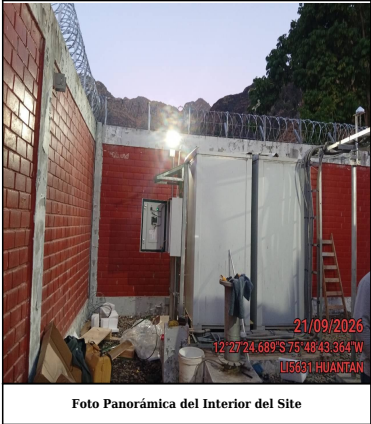
Foto Panorámica del Interior del Site
