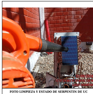
FOTO LIMPIEZA Y ESTADO DE SERPENTIN DE UC
