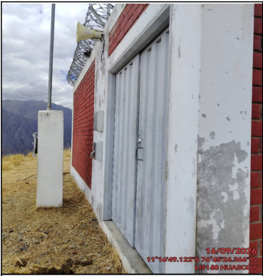
Pozo a tierra
