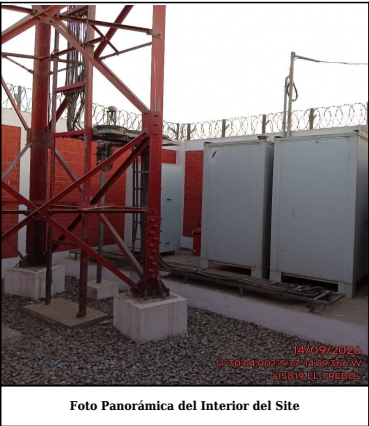
Foto Panorámica del Interior del Site
