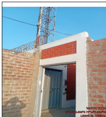
VISTA PANORAMICA DEL SITE
