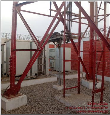
Foto Panorámica del Interior del Site
