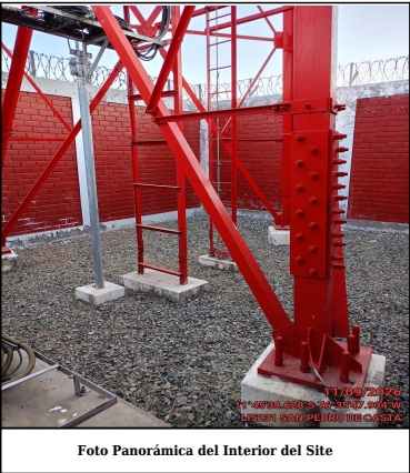
Foto Panorámica del Interior del Site
