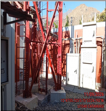
Foto Panorámica del Interior del Site
