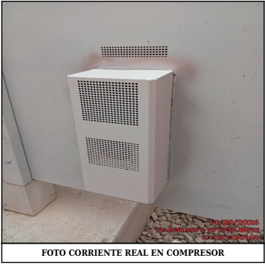
FOTO CORRIENTE REAL EN COMPRESOR
