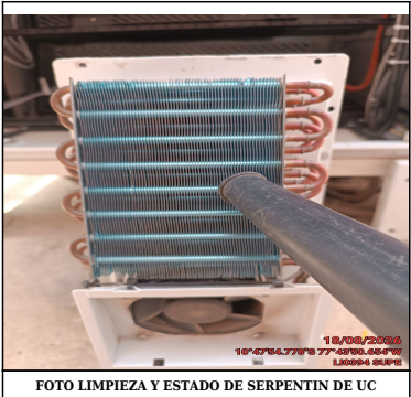
FOTO LIMPIEZA Y ESTADO DE SERPENTIN DE UC
