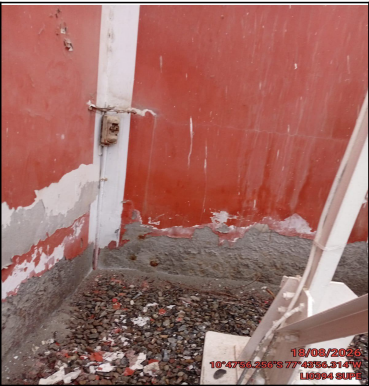
Foto Panorámica del Interior del Site
