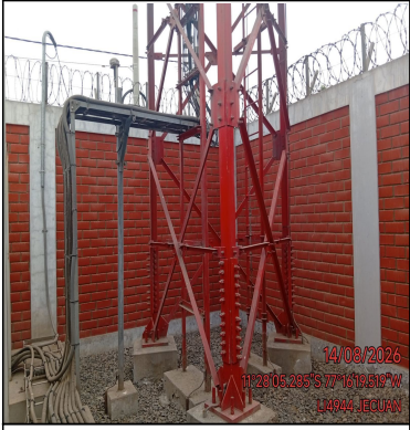
Foto Panorámica del Interior del Site
