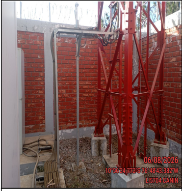
Foto Panorámica del Interior del Site
