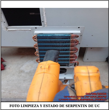
FOTO LIMPIEZA Y ESTADO DE SERPENTIN DE UC
