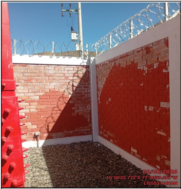
Foto Panorámica del Interior del Site
