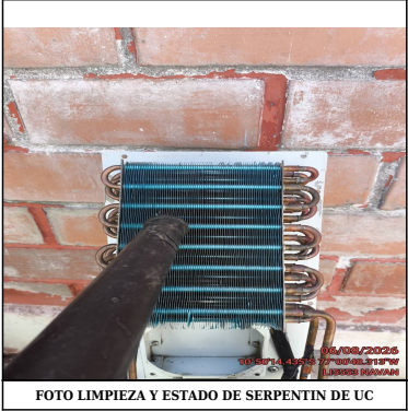
FOTO LIMPIEZA Y ESTADO DE SERPENTIN DE UC
