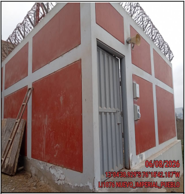
Pozo a tierra
