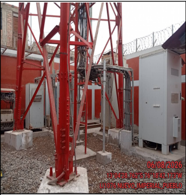
Foto Panorámica del Interior del Site
