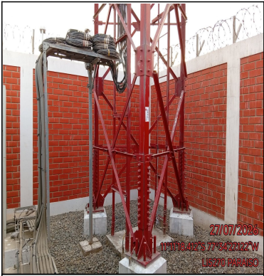
Foto Panorámica del Interior del Site
