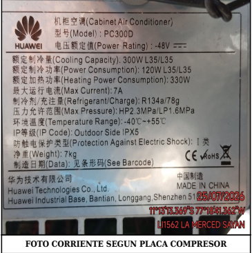
FOTO CORRIENTE SEGUN PLACA COMPRESOR
