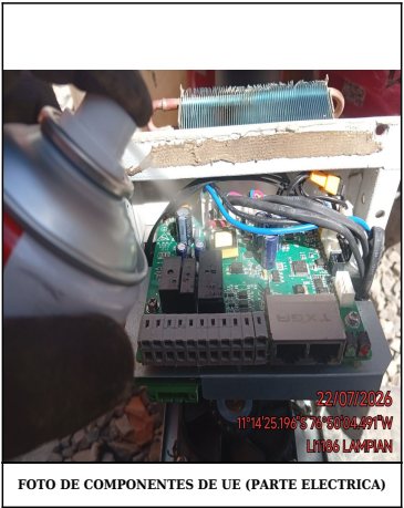
FOTO DE COMPONENTES DE UE (PARTE ELECTRICA)
