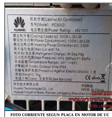
FOTO CORRIENTE SEGUN PLACA EN MOTOR DE UC
