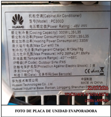
FOTO DE PLACA DE UNIDAD EVAPORADORA
