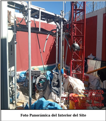
Foto Panorámica del Interior del Site
