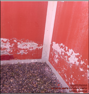
Foto Panorámica del Interior del Site
