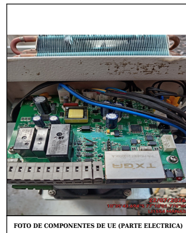
FOTO DE COMPONENTES DE UE (PARTE ELECTRICA)
