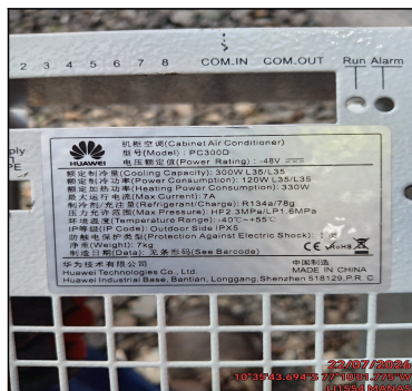
FOTO DE PLACA DE UNIDAD EVAPORADORA
