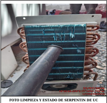
FOTO LIMPIEZA Y ESTADO DE SERPENTIN DE UC
