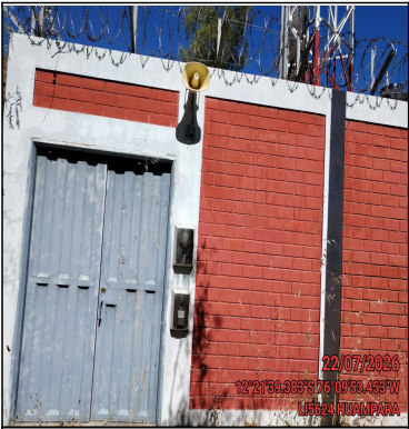
Pozo a tierra
