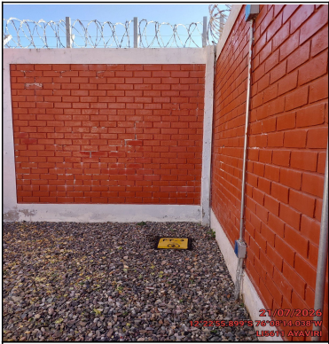
Foto Panorámica del Interior del Site
