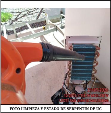
FOTO LIMPIEZA Y ESTADO DE SERPENTIN DE UC
