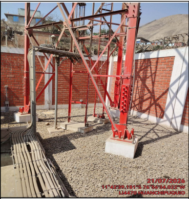
Foto Panorámica del Interior del Site
