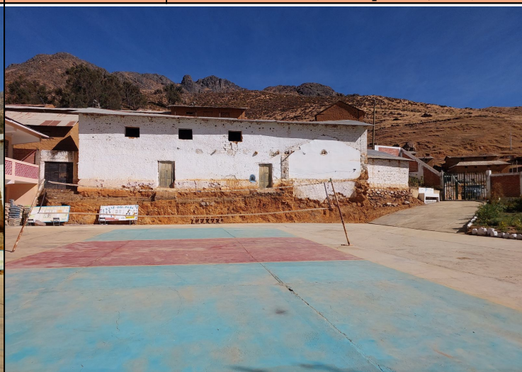
Foto tomada del NOC
