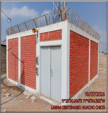
Pozo a tierra
