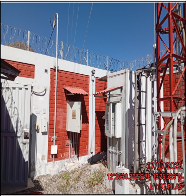
Foto Panorámica del Interior del Site
