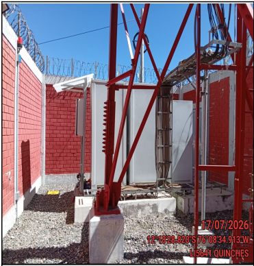
Foto Panorámica del Interior del Site
