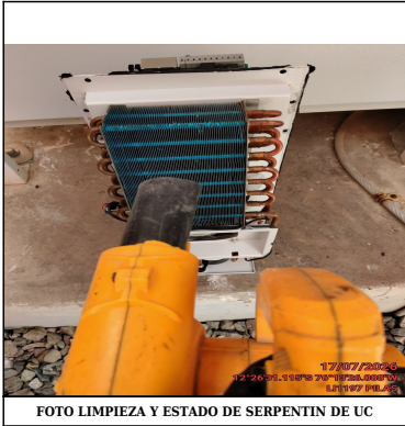
FOTO LIMPIEZA Y ESTADO DE SERPENTIN DE UC
