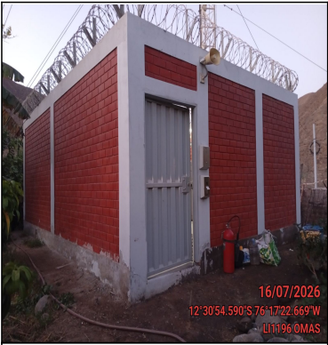
Pozo a tierra
