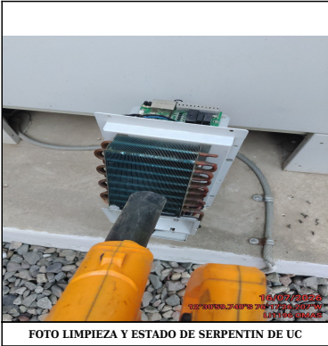
FOTO LIMPIEZA Y ESTADO DE SERPENTIN DE UC
