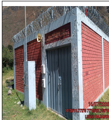
VISTA PANORAMICA DEL SITE
