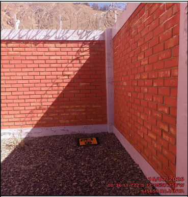
Foto Panorámica del Interior del Site
