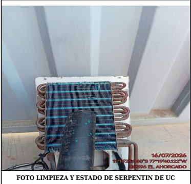
FOTO LIMPIEZA Y ESTADO DE SERPENTIN DE UC
