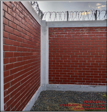
Foto Panorámica del Interior del Site
