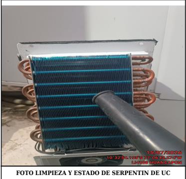
FOTO LIMPIEZA Y ESTADO DE SERPENTIN DE UC
