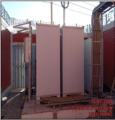
Foto Panorámica del Interior del Site
