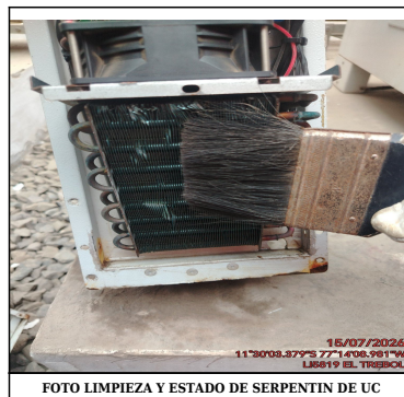
FOTO LIMPIEZA Y ESTADO DE SERPENTIN DE UC
