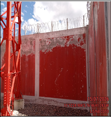
Foto Panorámica del Interior del Site
