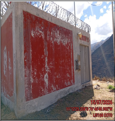
Pozo a tierra
