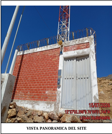
VISTA PANORAMICA DEL SITE
