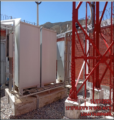
Foto Panorámica del Interior del Site
