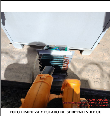
FOTO LIMPIEZA Y ESTADO DE SERPENTIN DE UC
