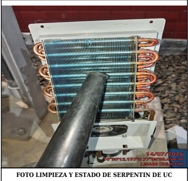
FOTO LIMPIEZA Y ESTADO DE SERPENTIN DE UC
