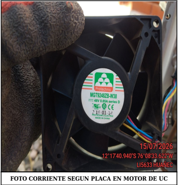
FOTO CORRIENTE SEGUN PLACA EN MOTOR DE UC
