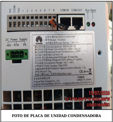
FOTO DE PLACA DE UNIDAD CONDENSADORA
