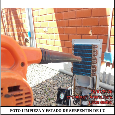
FOTO LIMPIEZA Y ESTADO DE SERPENTIN DE UC
