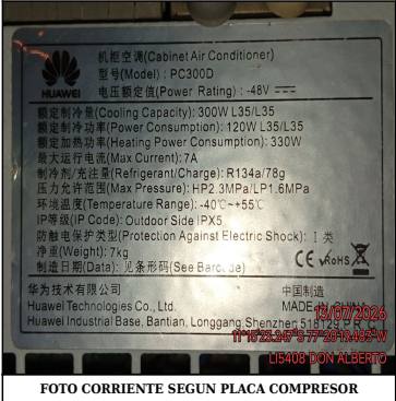
FOTO CORRIENTE SEGUN PLACA COMPRESOR
