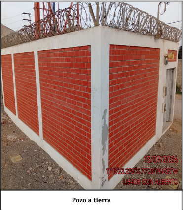
Pozo a tierra
