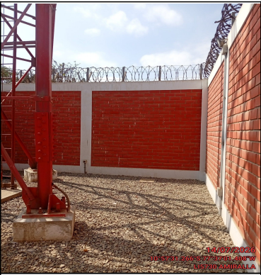
Foto Panorámica del Interior del Site
