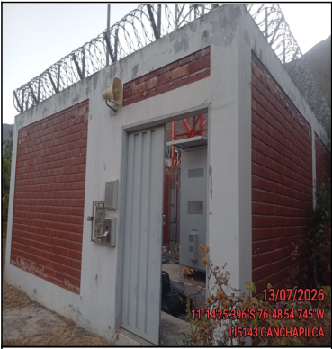
Pozo a tierra
